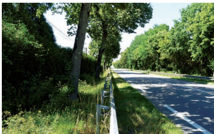
1,30 m entre arbre et glissière, 1,90 m entre glissière et ligne de rive : pas parfait, mais le risque d'aggravation d'une sortie de route s'éloigne.
