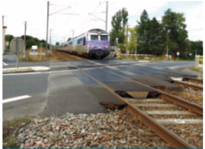
Ici, la visibilité des automobilistes ne permet pas de voir arriver les trains qui passent à 140 km/h : à cette vitesse (39 mètres parcourus par seconde) et dans le court délai entre fermeture des barrières et passage du train, il devient impossible d'éviter un drame.
