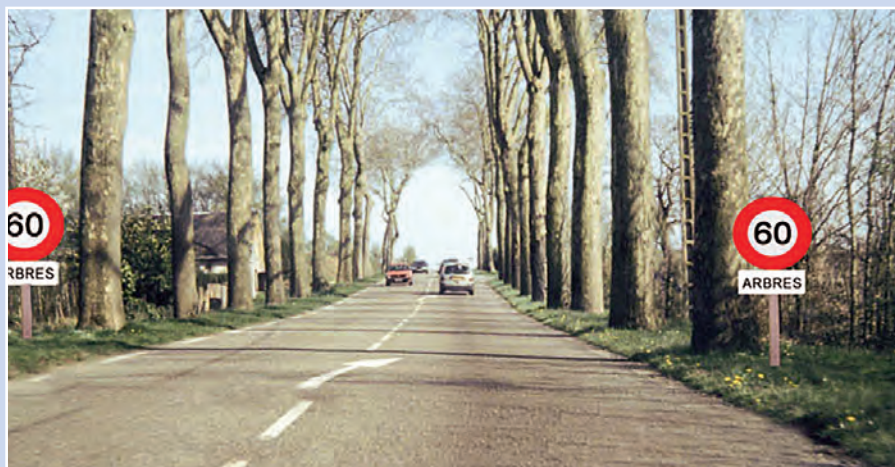
Les beaux alignements sont à conserver. Trop proches pour poser des glissières. Leurs courtes longueurs permet d'imposer le 60.
