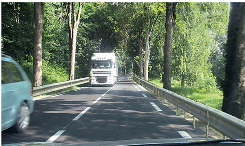
Arbres à moins de 2,50 m : les glissières occasionnent des collisions frontales.
